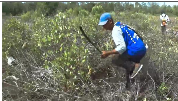
右後ろの作業員は、自前の草刈り機を使って作業を行っている。
